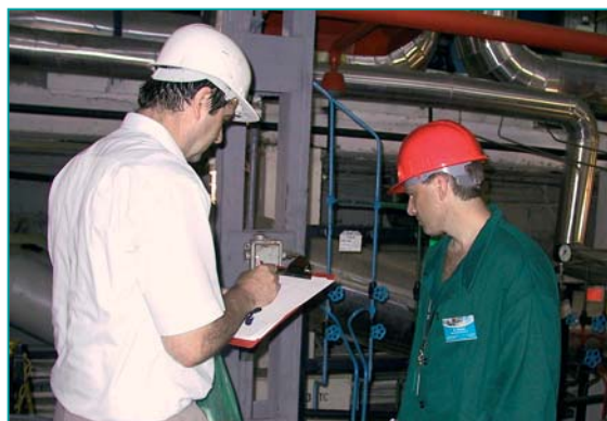
Обход на машинната зала на III и IV блок
