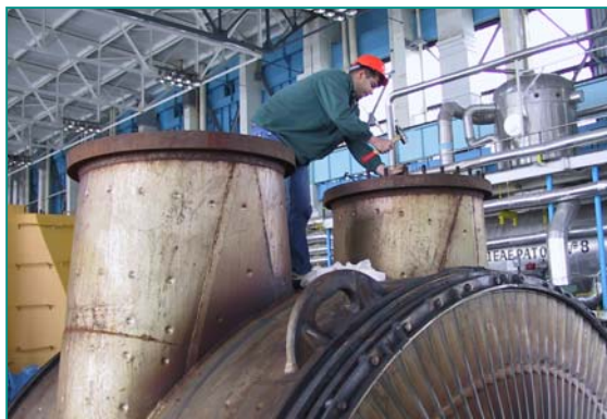
На 1 април започна ремонтната кампания на четвърти блок
