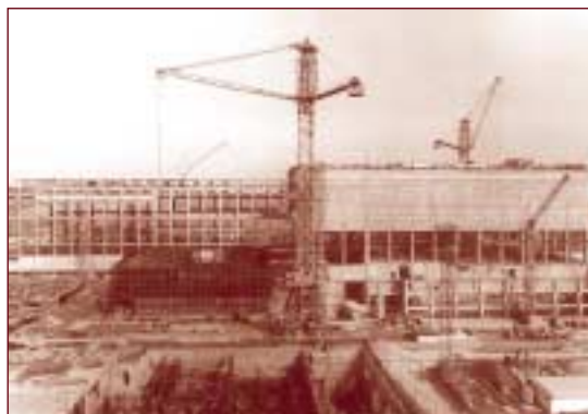
Строителството на трети и четвърти блок, 1976 г.
