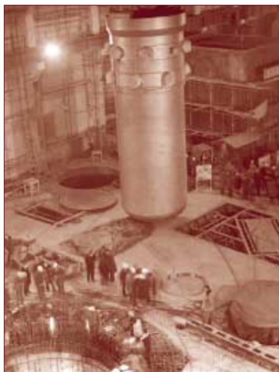
Монтаж на първи реактор
