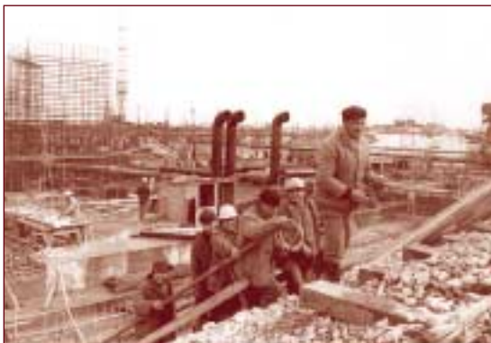
Изграждане на естакадата на главния корпус на първи блок, 1971 г.
