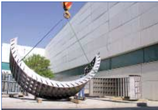
Монтаж на струйно-вихров кондензатор на трети блок, 2002 г.
