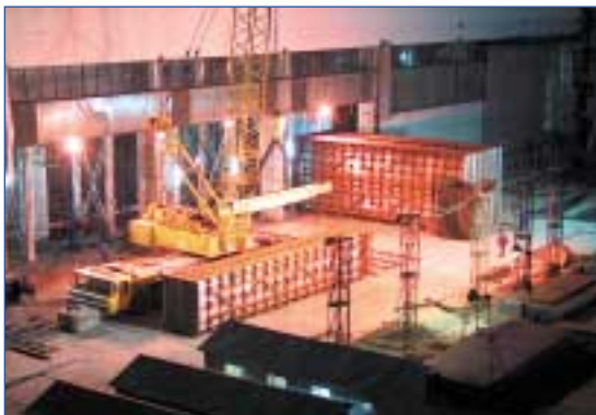
Подмяна на тръбните снопове на кондензаторите на шести блок, 2003 г.
