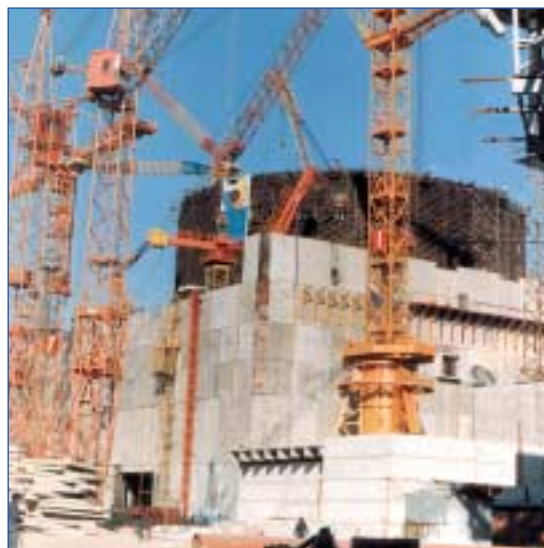
Строителство на шести блок, октомври 1986 г.
