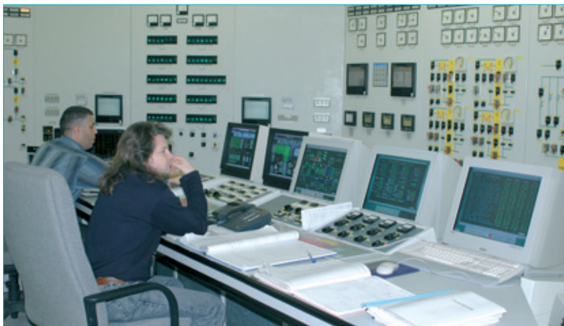
Апаратура УВС – Ovation в командната зала на шести блок
