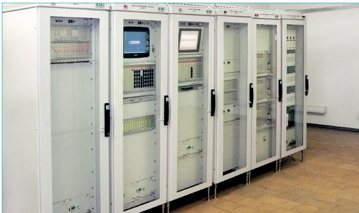
Панели от Унифициран комплекс технически средства на изпитателния полигон в ЗАД НПП "Рагий", които ще бъдат монтирани на втора система за безопасност на 6 блок
