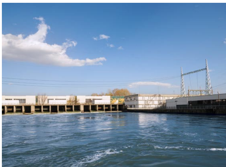
Брегова помпена станция-2
