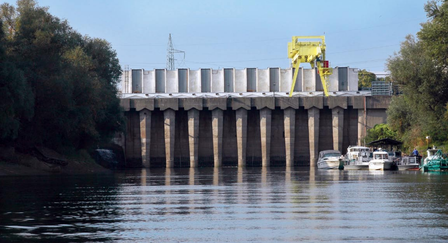
Брегова помпена станция-1 с подводящия канал
