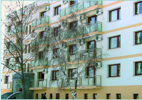
Общежитието след ремонта
