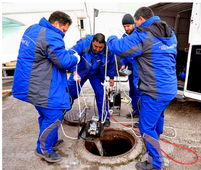
Изпитване на тръбопровод чрез визуален метод с дистанционни средства
