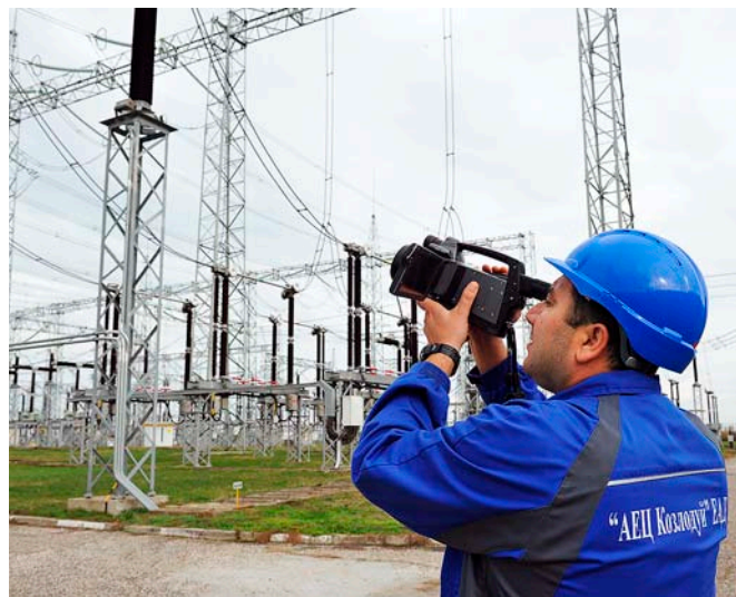
Термовизионен контрол на съоръжения на Открита разпределителна уредба
