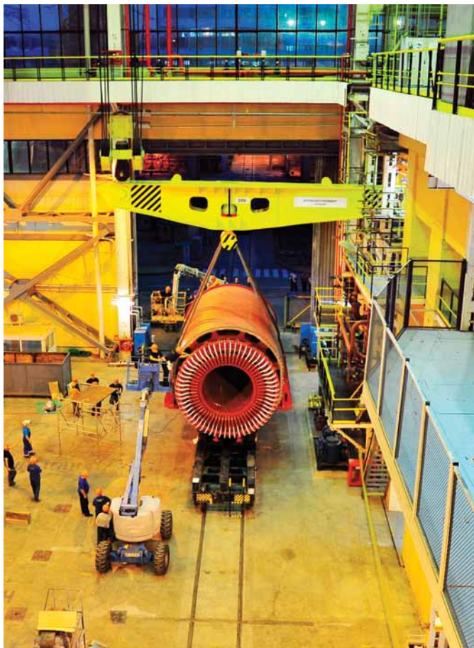
Мащабната операция по замяната на статора на турбогенератор 10 бе изпълнена на 16 септември
