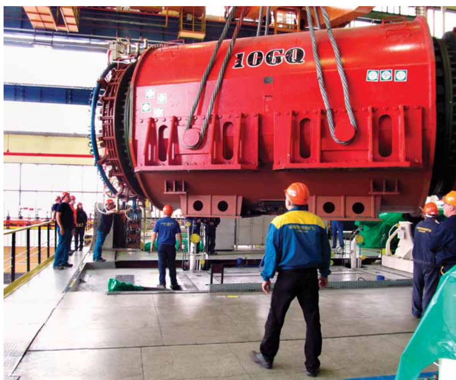
Демонтаж на статора на 6 блок, 13 септември 2015 г.
