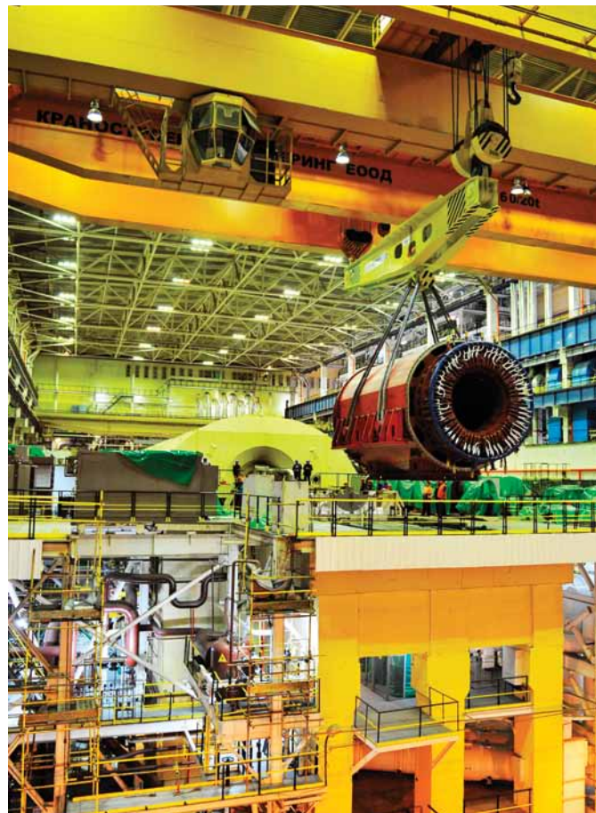
Мащабната операция по замяната на статора на турбогенератор 10 бе изпълнена на 16 септември
