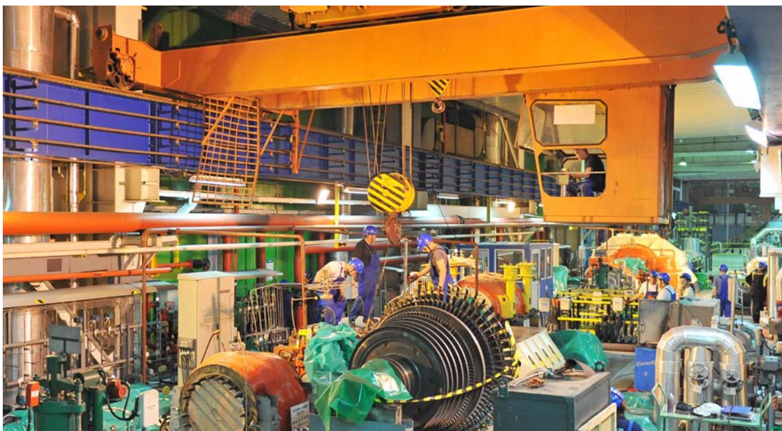
По време на плановия годишен ремонт на 5 блок, който се провежда от 9 април до 16 май т. г., бяха реализирани редица мерки по проектите за продължаване на срока на експлоатация и за повишаване на топлинната мощност на реактора
