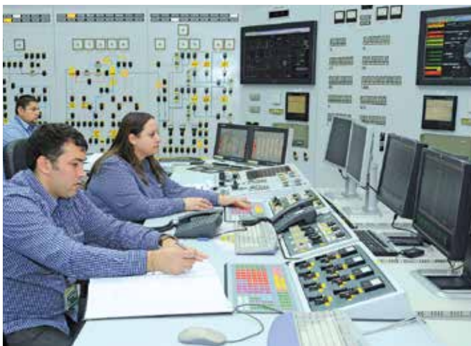
Обучение в Пълномащабния симулатор за блокове ВВЕР-1000 в Учебно-тренировъчния център на АЕЦ "Козлодуй"
