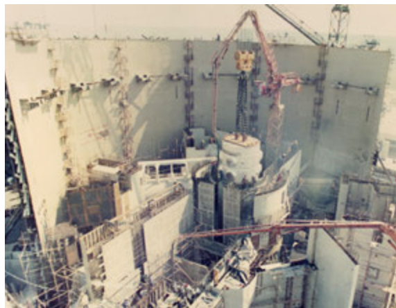
Монтаж на корпуса на реактора, април 1985 г.
