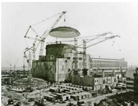
Монтаж на купола на пети блок, септември 1985 г.
