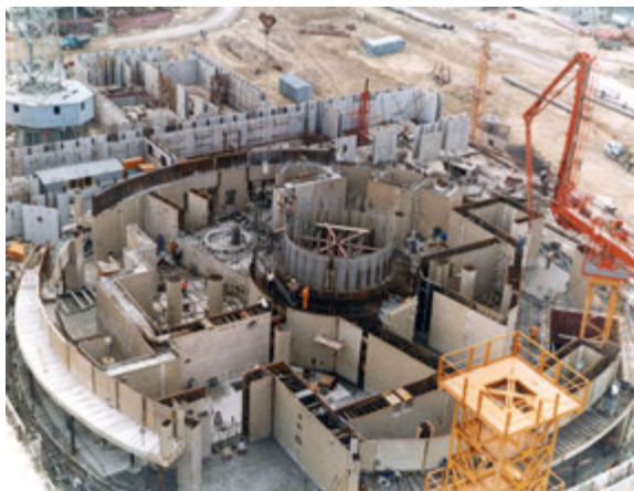
Строителство на реакторно отделение, юни 1984 г.
