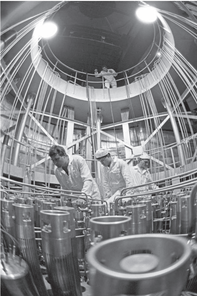
Проверка на датчиците на системите на горния блок на пети реактор, юни 1987 г.
